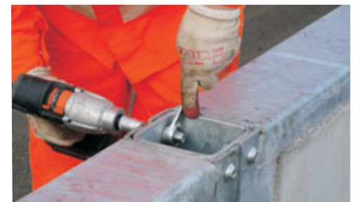
Schnelle Montage, denn pro 10 m-Element müssen nur zwei Schrauben fixiert werden.
